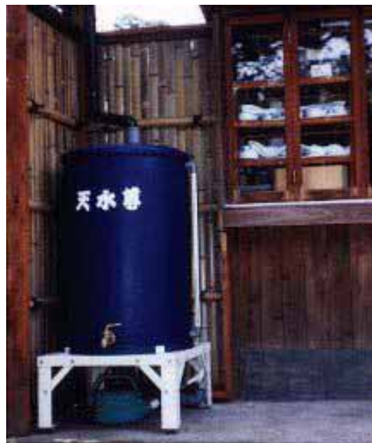
図 3.2.2 雨水タンクによる雨水貯留（各戸貯留対策）
