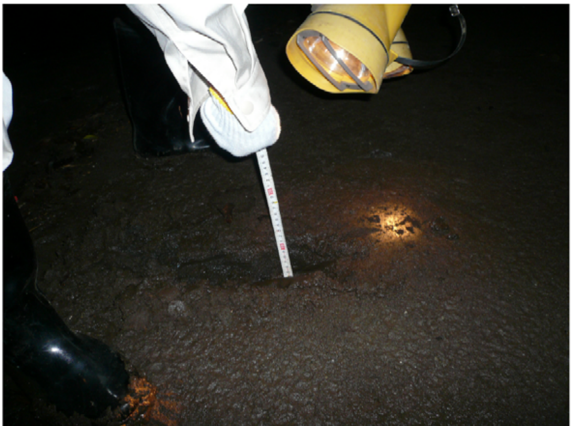
図 5.1.1 地下貯留槽に貯まった土砂
