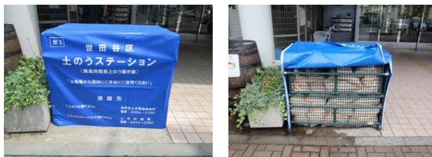
写真 7-1 土のうステーションの例（世田谷区）
