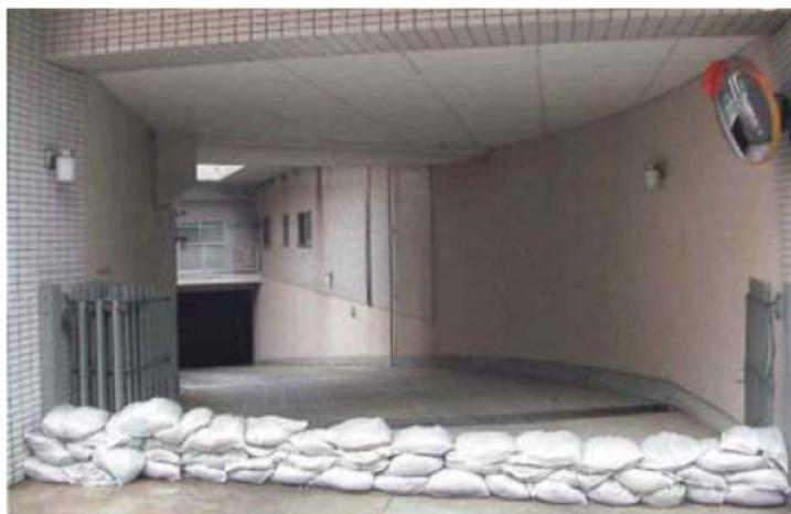
写真 7-2 地下への浸水防止対策の例
