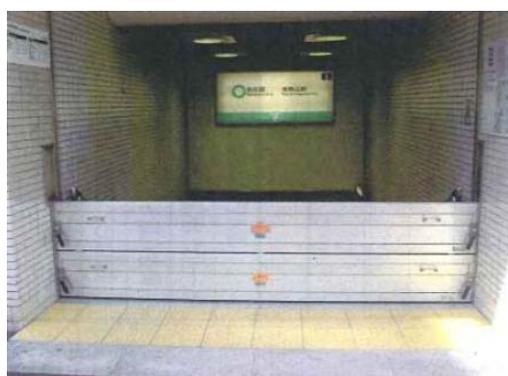
写真 7-3 止水板による地下浸水対策の例
