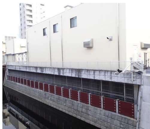
写真 2-3 取水口（養老橋下流右岸）
