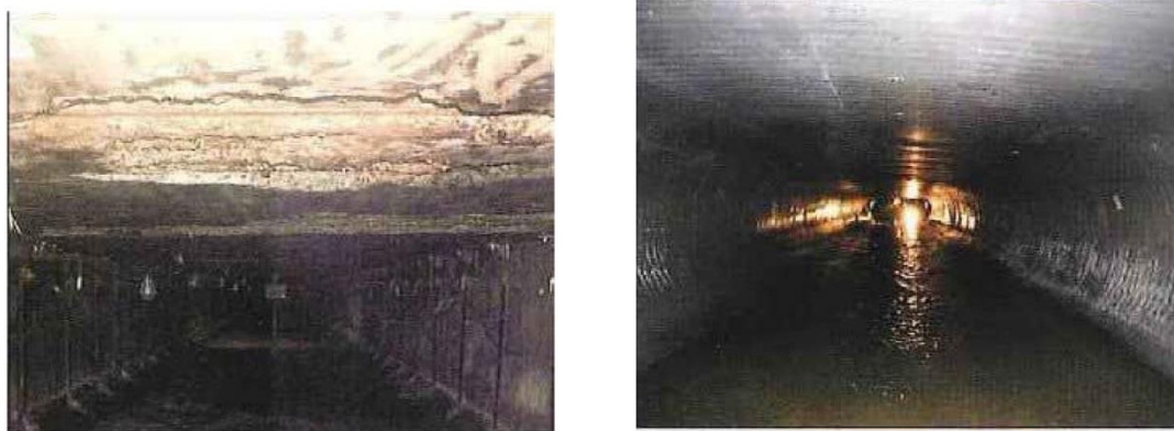
写真2-4 青山幹線の再構築（左：施工前 右：施工後）
