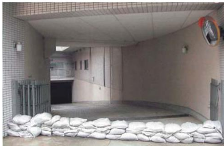
写真 6-2 地下への浸水防止対策の例
