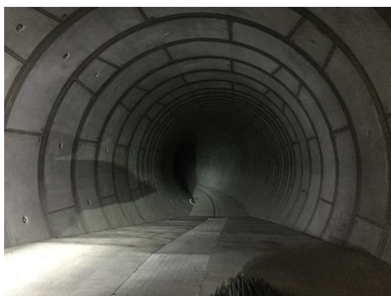
写真 2-2 地下調節池の内部
