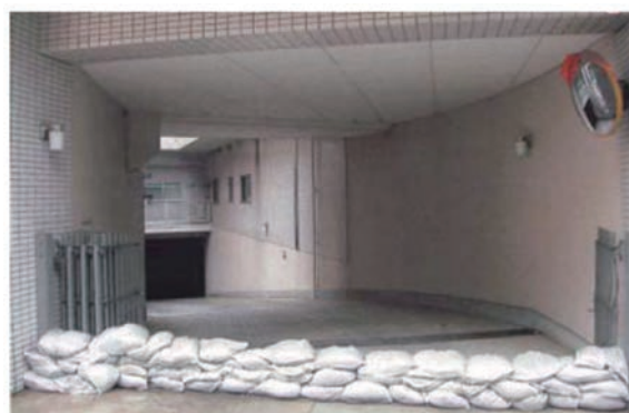
写真 7-2 地下への浸水防止対策の例
