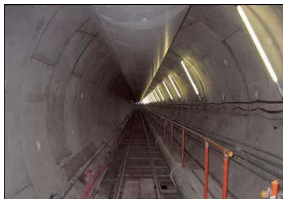
写真 4-2 建設中の幹線
