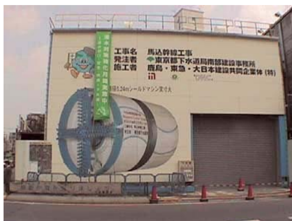
写真 4-1 幹線工事作業基地
