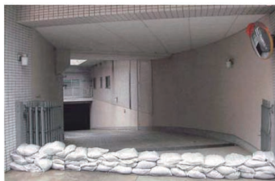
写真 7-2 地下への浸水防止対策の例
