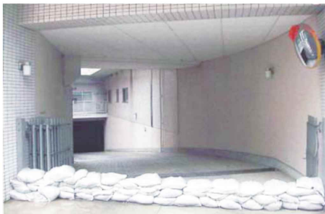
写真 7-2 地下への浸水防止対策の例
