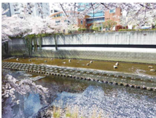
写真 2-1 船入場調節池
