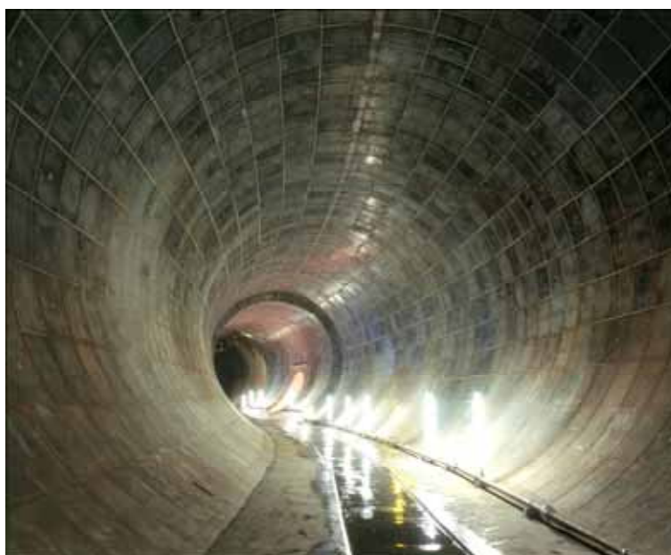
写真 4-1 和田弥生幹線（内径 8.5m、貯留量 15 万 m 3 ）
