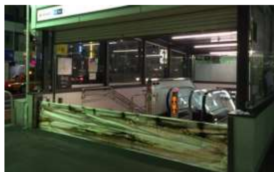
写真 止水板設置例
