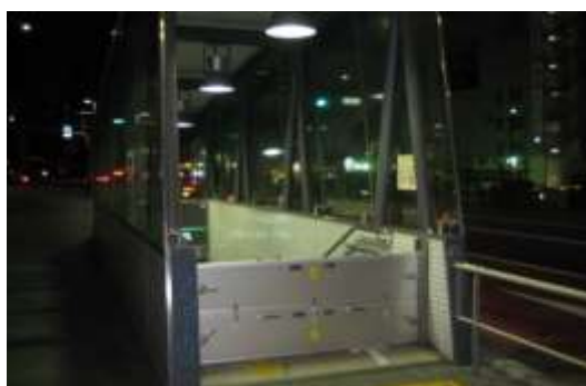
写真 止水板設置例
