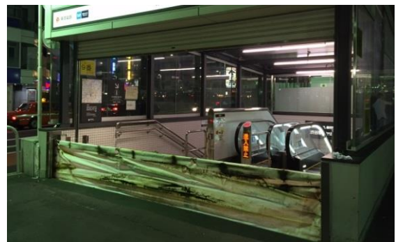
写真 止水板設置例
