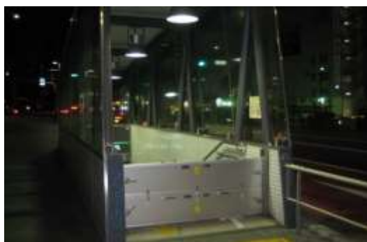
写真 止水板設置例
