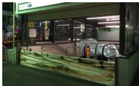
写真 止水板設置例
