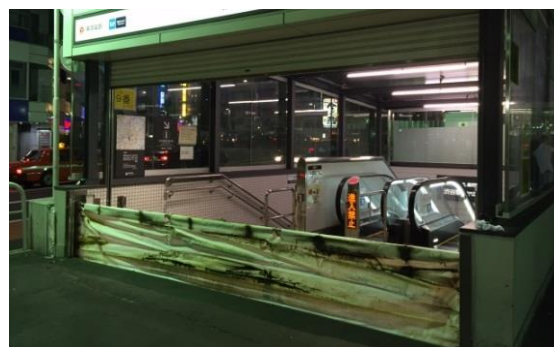
写真 止水板設置例
