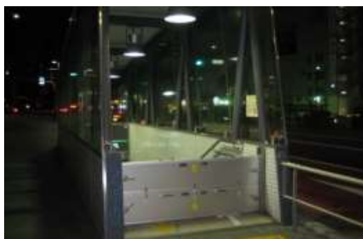
写真 止水板設置例
