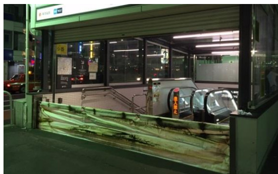
写真 止水板設置例
