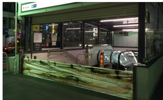
写真 止水板設置例
