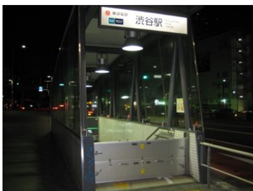
写真 止水板設置例
