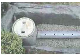
浸透トレンチ
