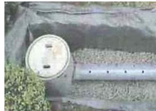
浸透トレンチ
