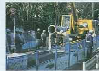
道路をほって下水道管をうめる工事
