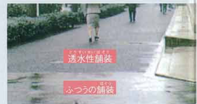
雨水をそのまま地面にしみこませる舗装です。手前はふつうの舗装
