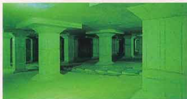
南元町雨水調整池 (新宿区)
