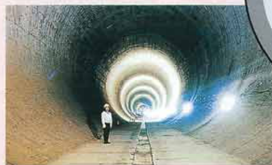
神田川・環状七号線地下調整池
