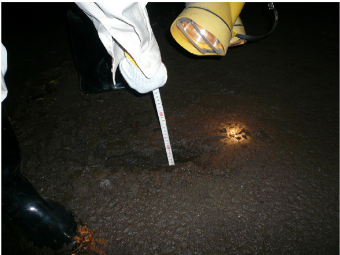
図-26 地下貯留槽に貯まった土砂
