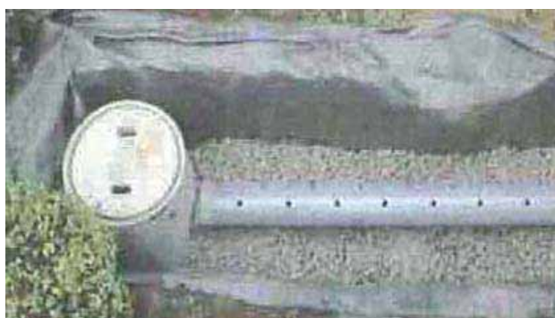
写真 4-1 「浸透ます」と「浸透トレンチ」
