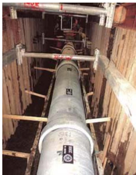
写真 4-2 管きょの布設状況
