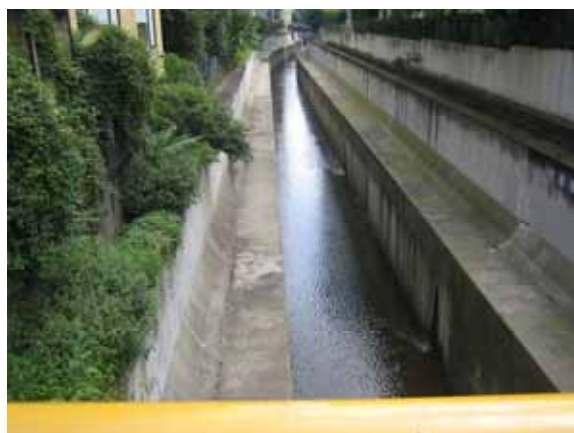
写真 4-2 清流復活事業により流量が回復した渋谷川
