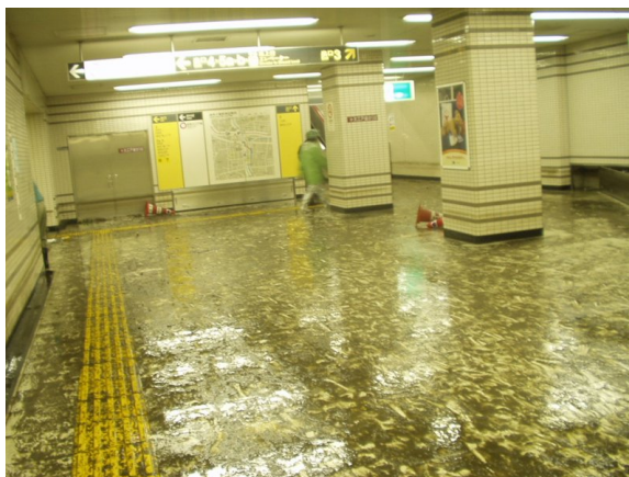
平成 16 年 10 月 9 日台風 22 号地下鉄南北線麻布十番駅 コンコース広場の浸水後の状況
