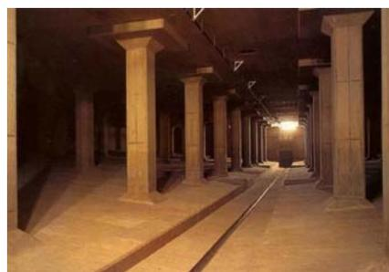
写真4-5 下水道の貯留施設(調整池)
