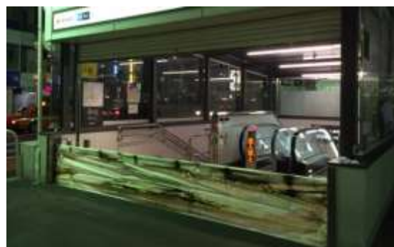
写真 止水板設置例
